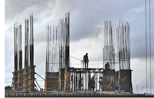
मानसून की आहत : केरल के कोच्चि में मंगलवार प्री-मानसून की बारिश के बादलों से भरे शाम में एक निर्माण स्थल पर काम कर रहे मजदूर।
