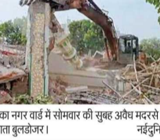
भिलाई के राधिका नगर वार्ड में सोमवार की सुबह अवैध मदरसे की बिल्डिंग को ढहता बुलडोजर। नईदुनिया
